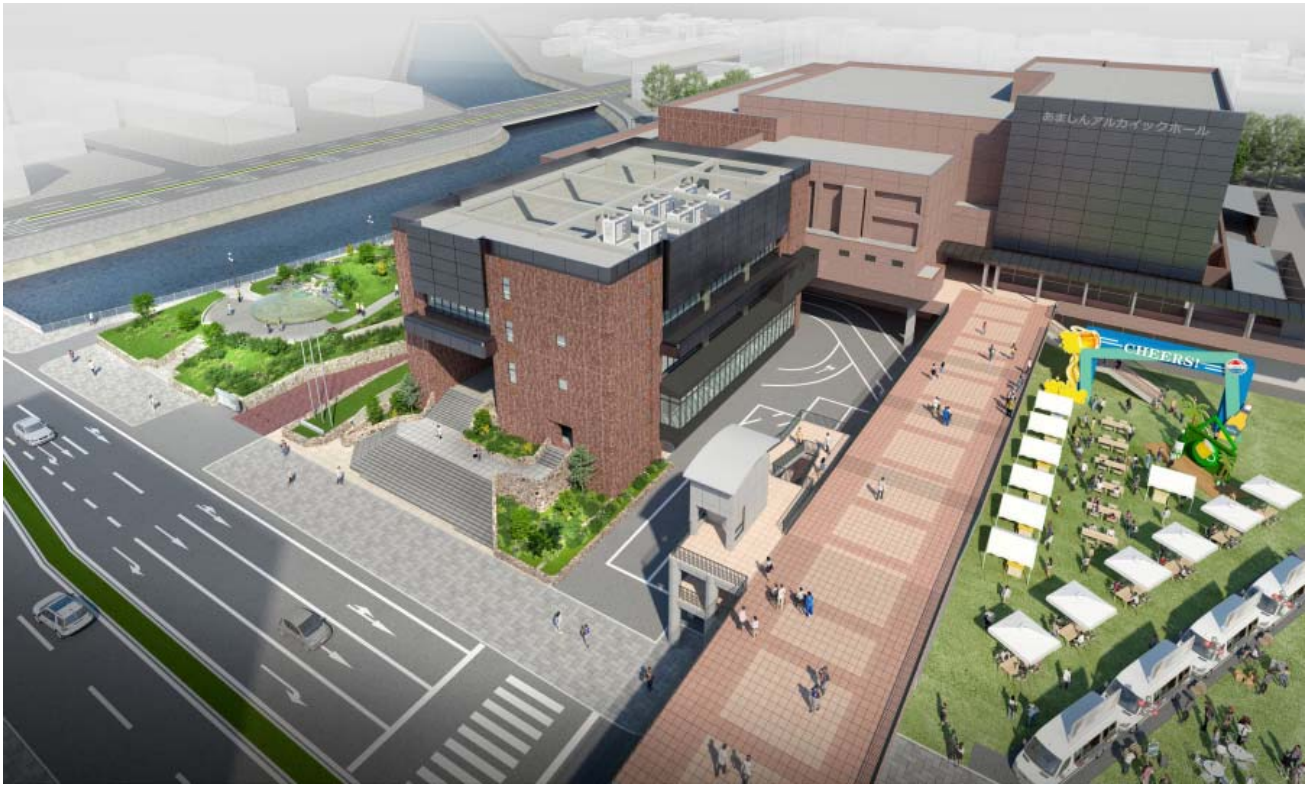
□図 「焼成頁岩打込 PC 版」と「スチール調特殊塗装」の外壁
