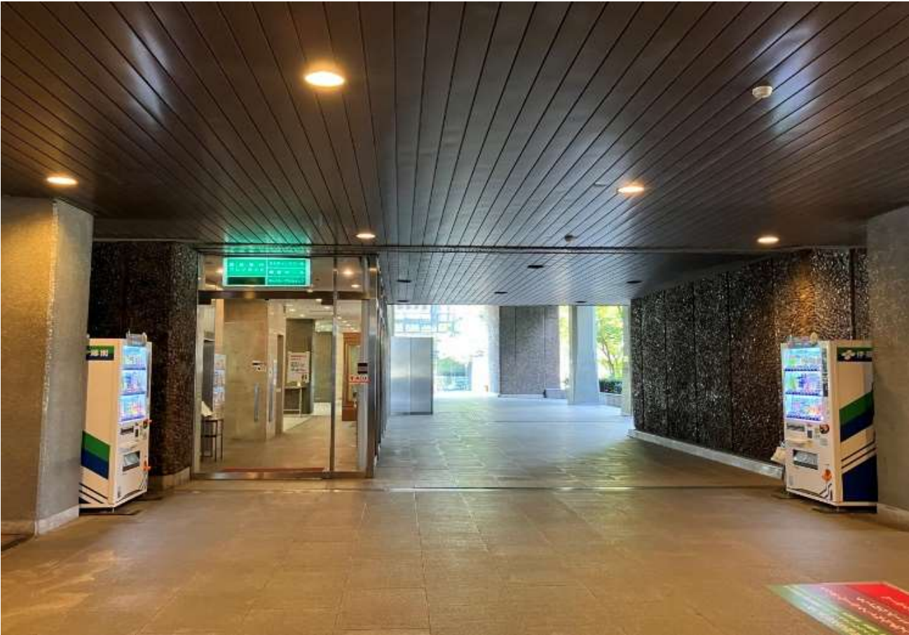
□現況写真 ホール棟コンコース（低天井部分・特定天井に非該当）から国道 2 号線方面を見る。
