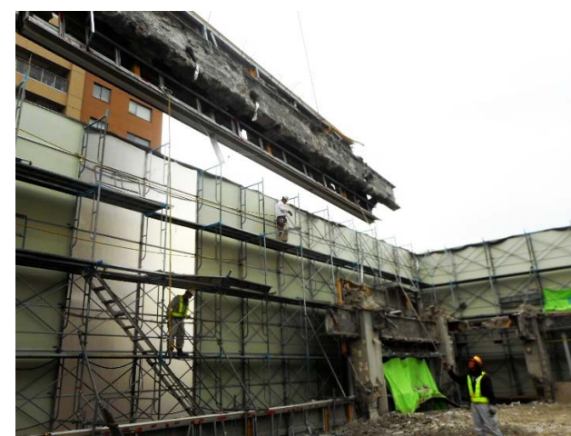
□参考写真 大梁の切断・玉吊
