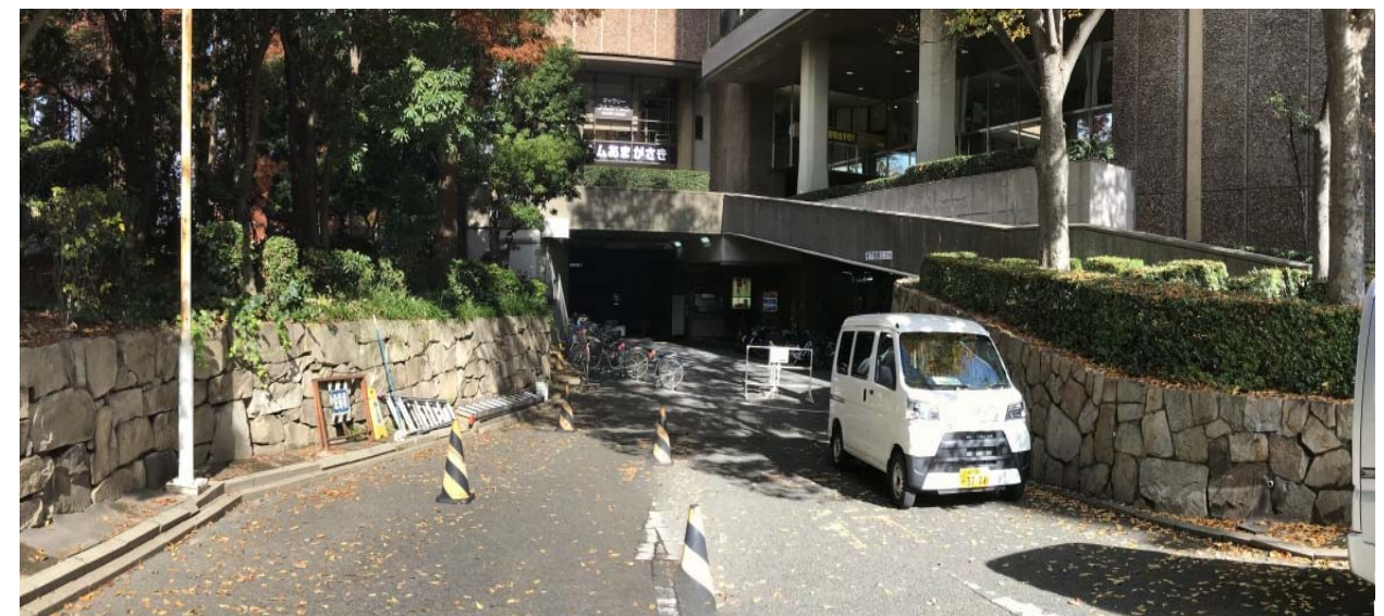
□現況写真 現スロープは歩行者（高齢者等含む）用としては設計されていない。
