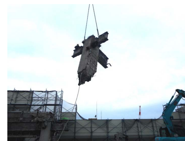
□参考写真 柱の切断・玉吊
