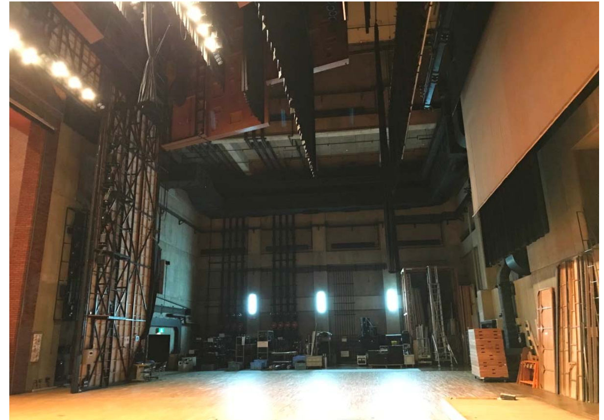
□現況写真 大ホール舞台下手（綱元は上手になっている。）
