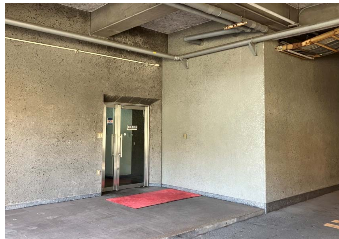
□現況写真 文化棟最終退出口
