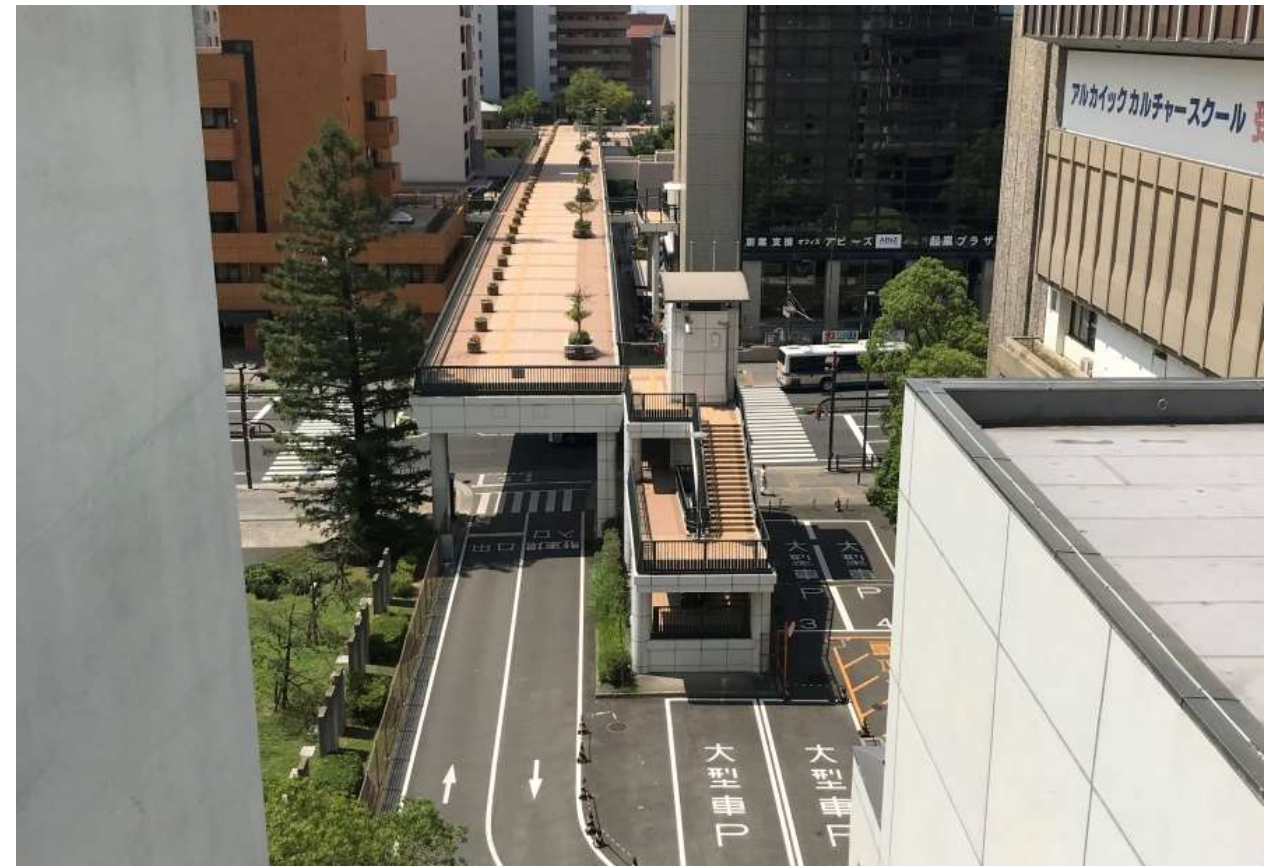
□写真 現状のペDESTリアンデッキ終点部分。本建物に到達する直前で国道2号線に降りるしかない。
