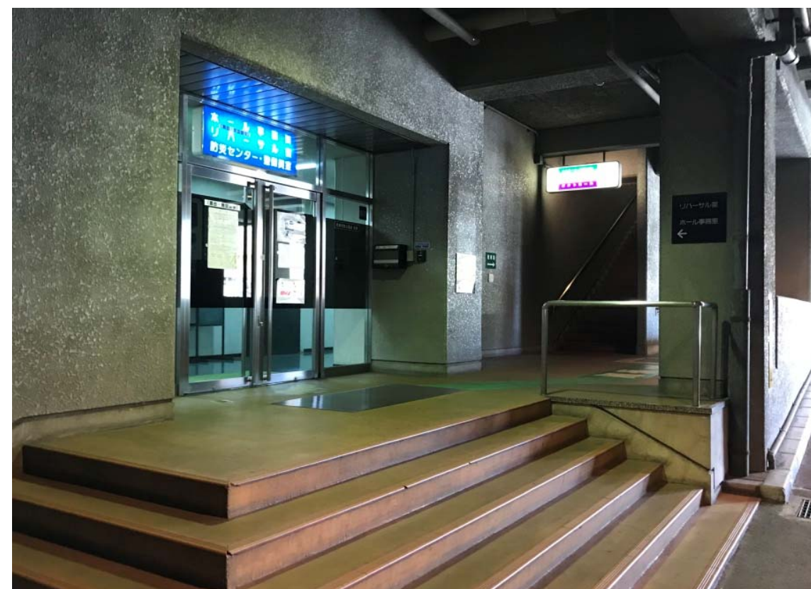
□現況写真 ホール棟最終退出口
