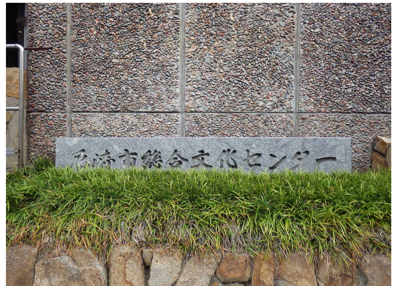
□写真 中2階レベルに設置されている既存花崗岩館名板。立派なものだが現状は視認性が悪い。
