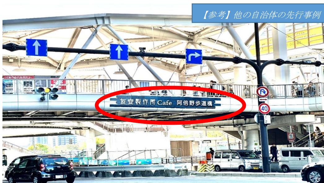
歩道橋に民間事業者等の屋外広告物の設置を認めた事例（天王寺駅前歩道橋）
