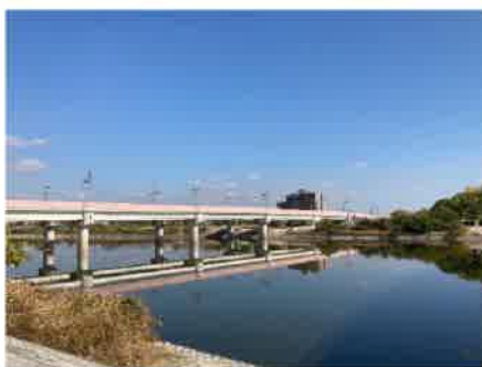
図 4.7 阪急神戸本線武庫川橋りょう
