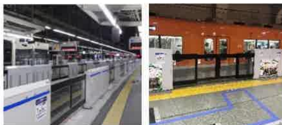
図 4.24 ホーム柵の設置
