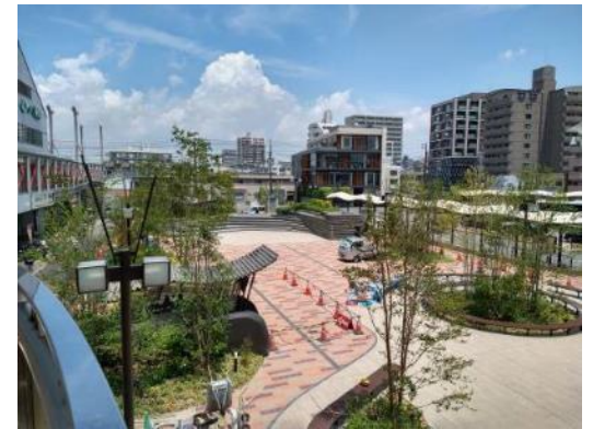
阪神出屋敷駅北側の改修
