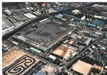
旧古河電気工業(株)尼崎工場の様子
