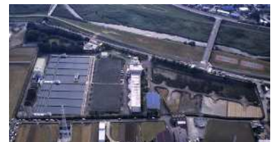
園田配水場 供用開始：昭和 42 年
