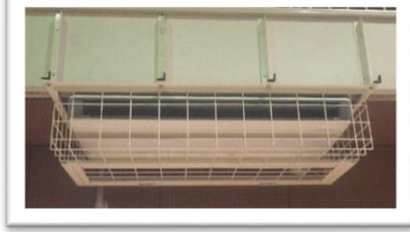
GHP 天吊り型の例
