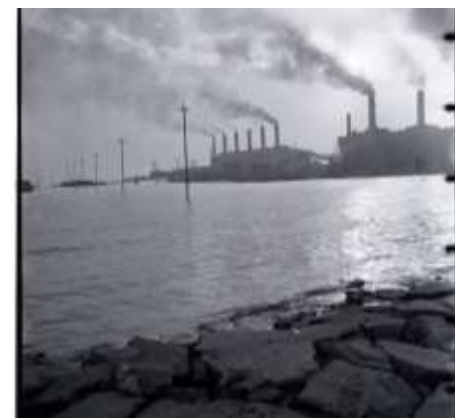
地盤沈下で水没した道路と関西電力 尼崎第一・第二発電所 (村井邦夫氏撮影)
