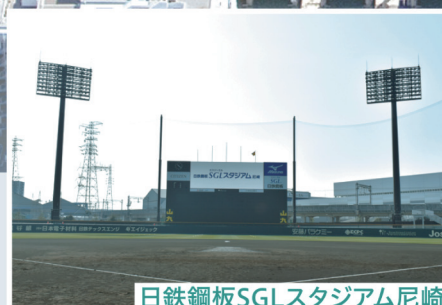
日鉄鋼板SGLスタジアム尼崎
